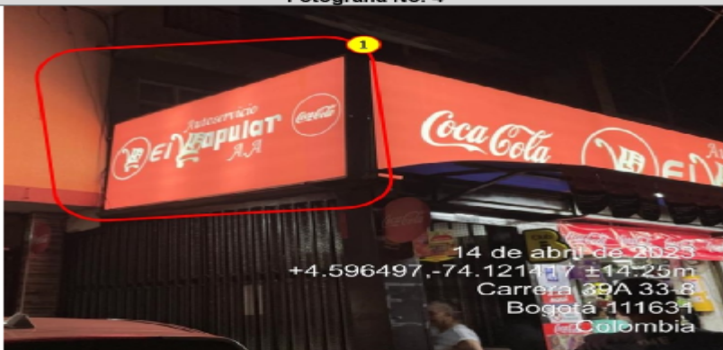
Elemento de PEV del establecimiento comercial, el cual se encuentra volado de la fachada de la edificación.
