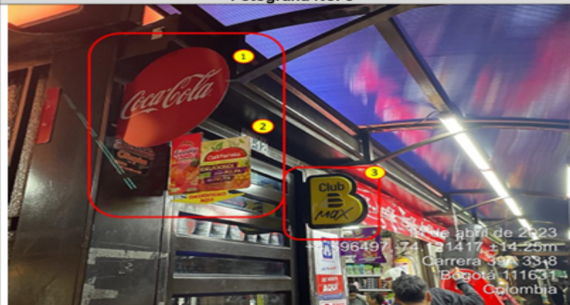
Elementos de PEV del establecimiento comercial, los cuales se encuentran volados de la fachada de la edificación.
